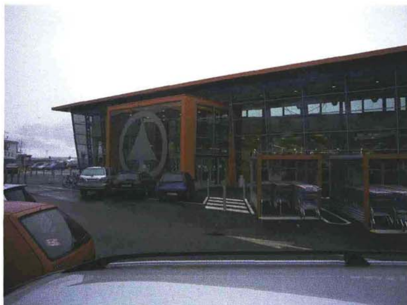
Prospetto principale del nuovo Interspar di San Lorenzo con la grande bussola d'ingresso.
