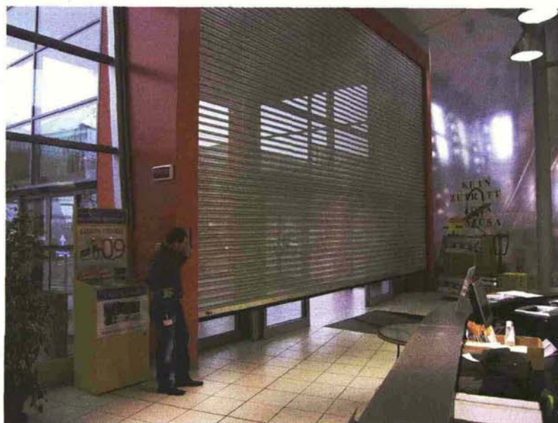
Particolare della serranda avvolgibile Hörmann che garantisce la sicurezza dell'intero edificio, proteggendo la grande bussola d'ingresso.
